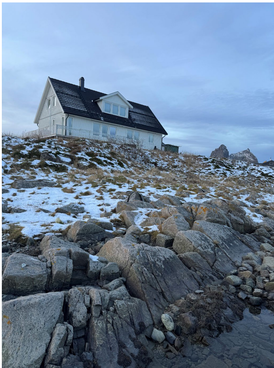
Figur 29. Bildet viser det ene bygningen som grenser til planområdet. Det fremkommer tydelig at bygningen er plassert på en fylling og at uteområdet således vil ligge høyere enn maksimal oppfylling av sandstranden jf. planbestemmelsene.
