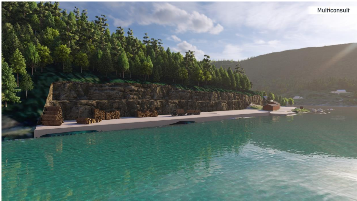
Figur 6-4: Tiltaket sett fra fjorden.
