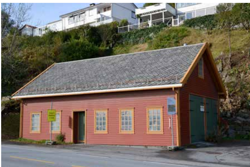
Eksisterende hovedrenseanlegg ligger i sentrum av Osøyro og er fra 1979. Bygget ligger ved siden av den gamle Osøren jernbanestasjonen som ble nedlagt i 1935. Foto: Kjell M. Jacobsen
