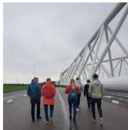
Maeslantkering, som er bygget for å kontrollere oversvømmelser i den sørlige delen av Nederland. Foto: AquariÅs
