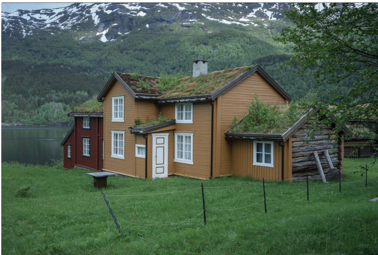
Bildet viser bebyggelse på Skjønstad gård.
