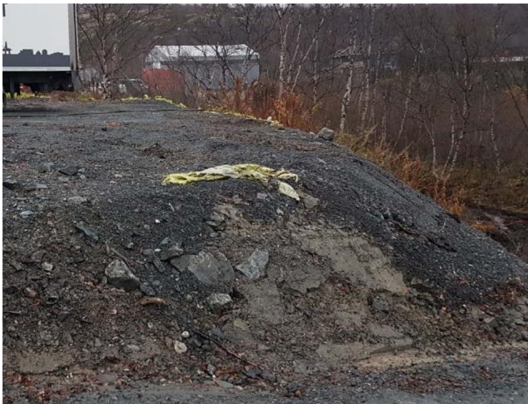
Foto av utfylling mot elvedal
