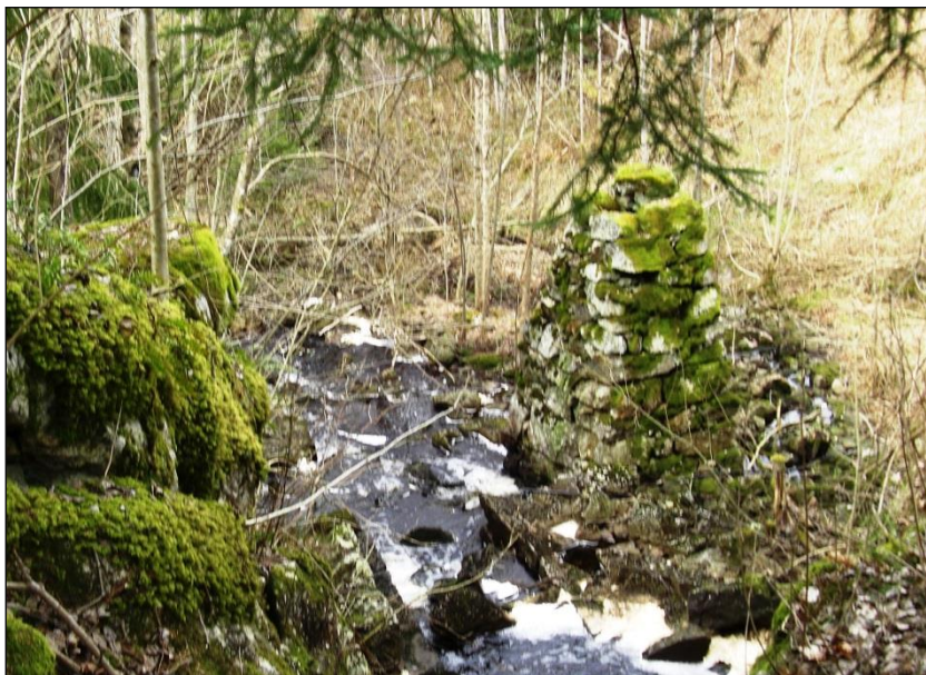
Fundament for møllebygning ved Brattfoss
