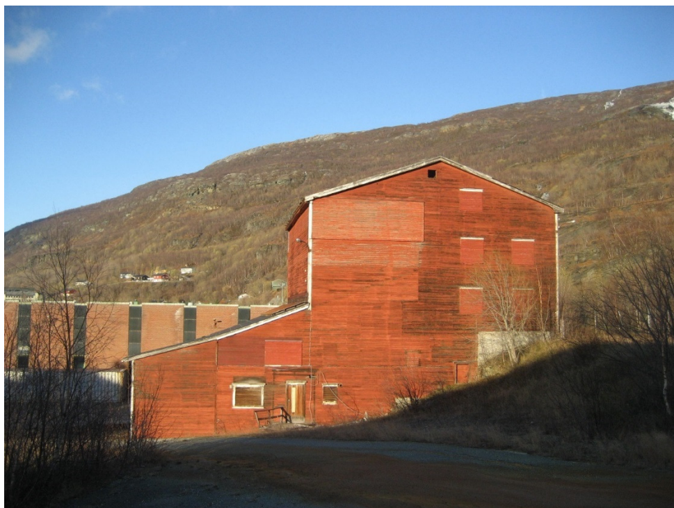
Figur 16. Sandneskontoret / Elmore-bygget. Foto; O-M Nøttveit. 2017
