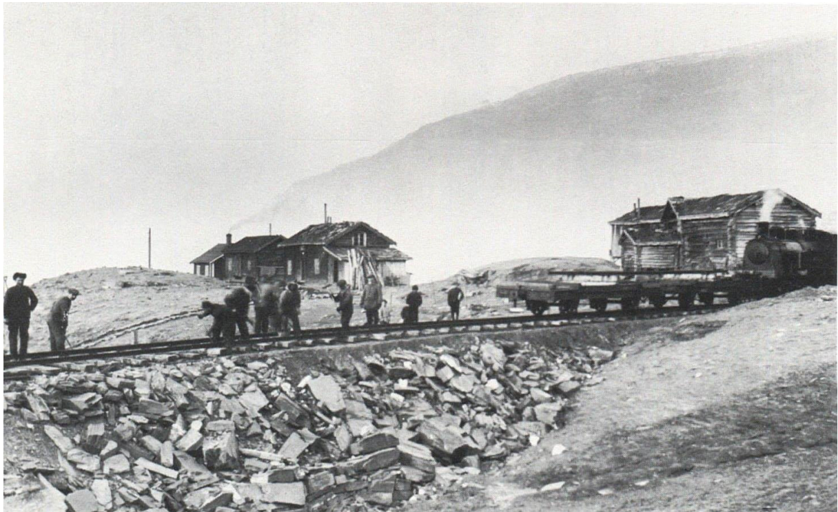
Figur 28. Reinshagen 1914. Anlegg av jernbanen («Nybanen») fram til Fagerli.
