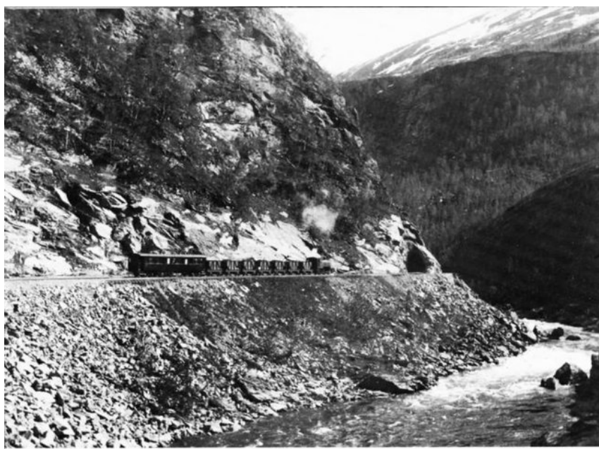
Figur 49. Stokkviknakken år 1915. Tertiærbanens trase synes til høyre for tunnelen. Kilde: Sulitjelmabanen. Foto: Kr. Helgesen.
