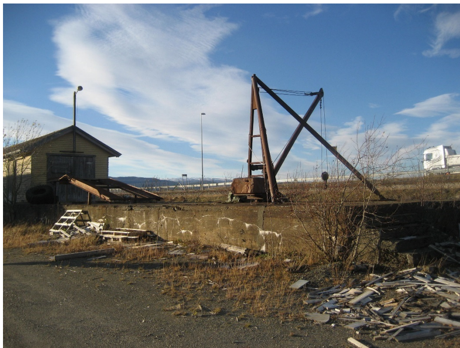
Figur 46. Godshus med perrong og lastekran på Finneid. Foto O-M Nøttveit 2017.
