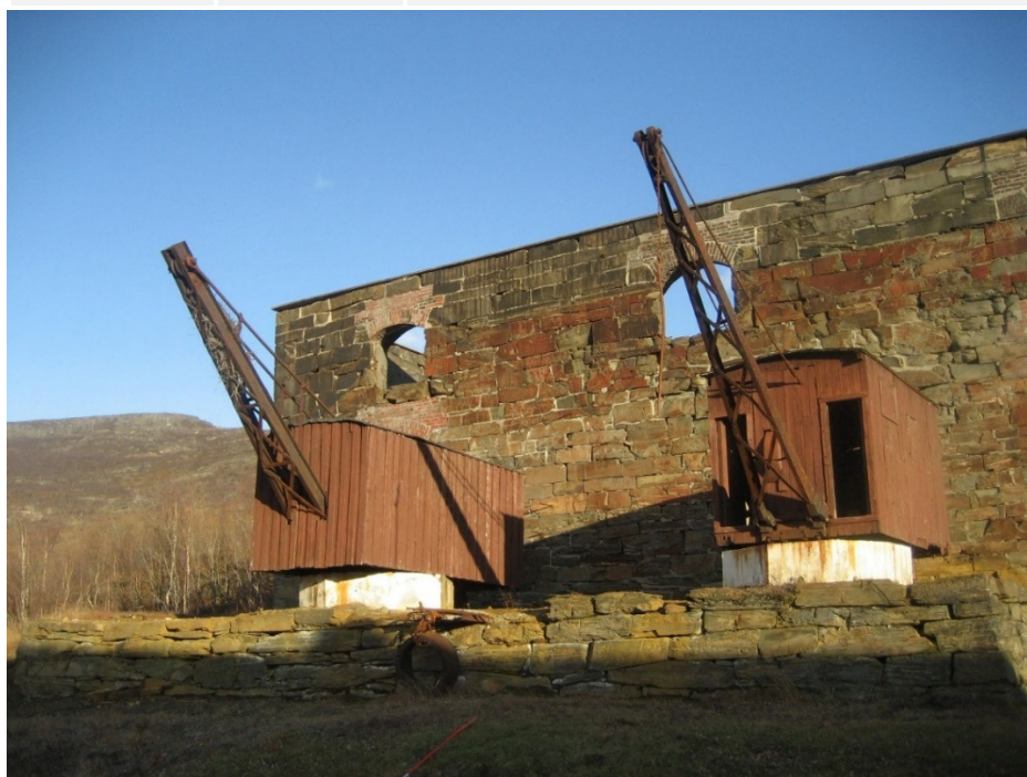
Figur 12. Smeltehytte Fagerli 2. To dampkraner fra kaianlegget ved Sjønstå er montert utenfor ruinen. Foto: O-M Nøttveit 2017. Tilsvarende kraner var montert på Hellarmo og på Fossen i en kortere periode.
