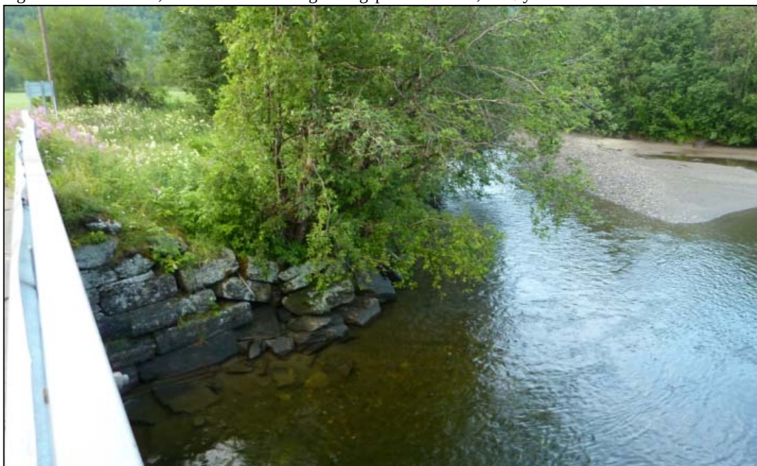
Fig 15 bilde mot nord ved kryssningssted over Storelva, ved siden av kjørevege.
