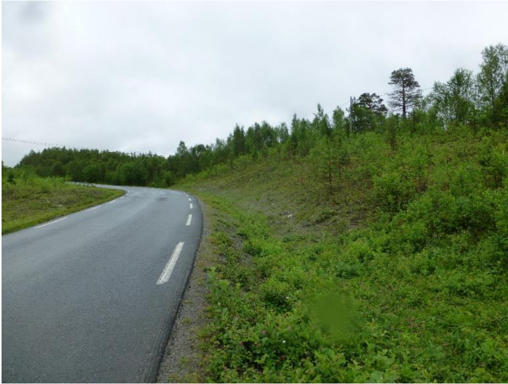
Figur 2: Svartvatnet. Bildet til venstre viser terrenget hvor tunnel skal krysse under eksisterende fv. 812. Det er ikke registrert bergblotninger her. Bildet til venstre viser hvordan terrenget ser ut i området for påhugget. Det er ikke registrert bergblotninger.
