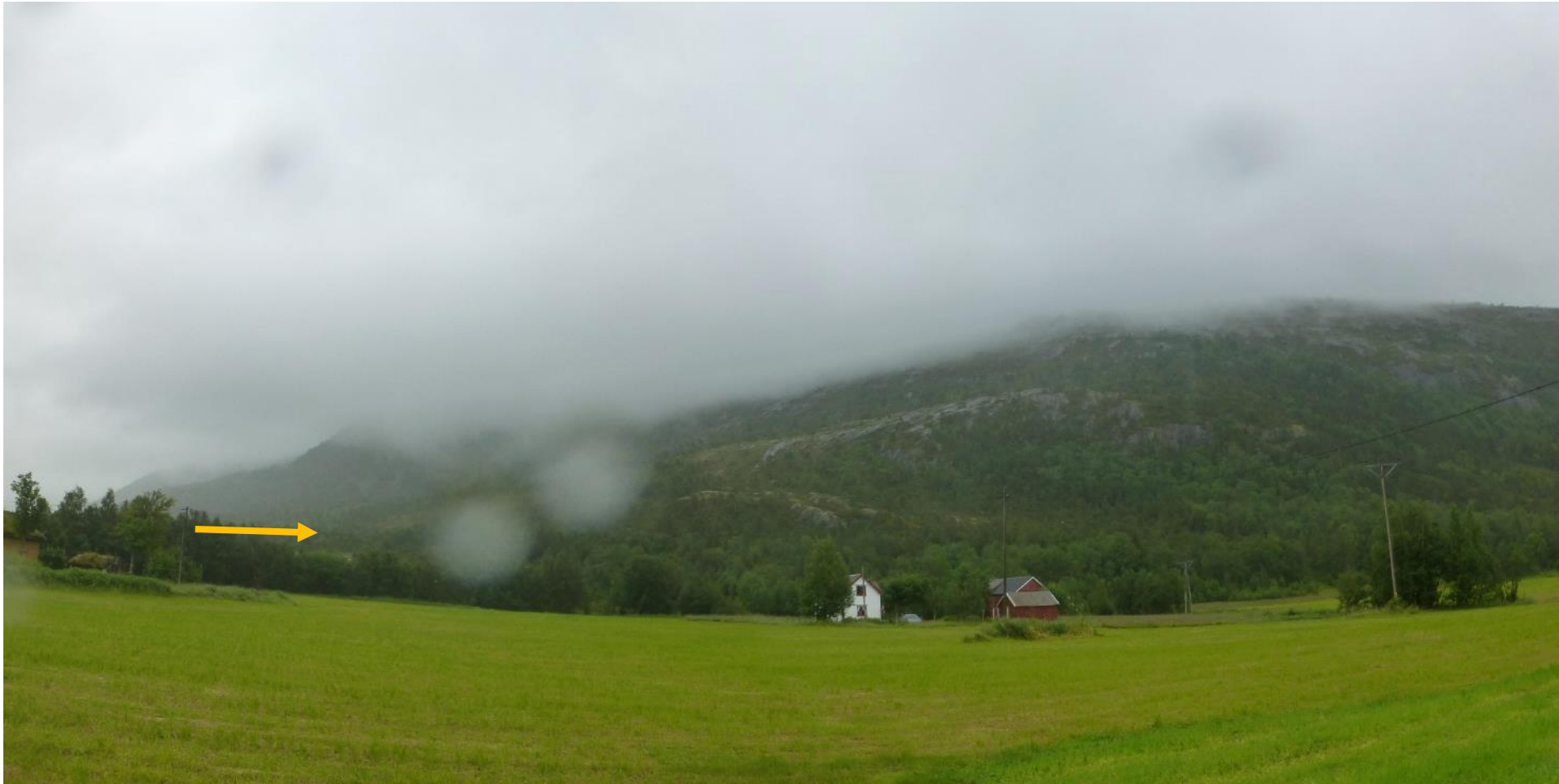
Figur 2: Oversikt over påhuggsområdet sett mot nord øst. På grunn av lavt skydekke og dårlig vær var det ikke mulig å få et bedre oversiktsbilde enn over. Se pil for ca. plassering av påhugg.
