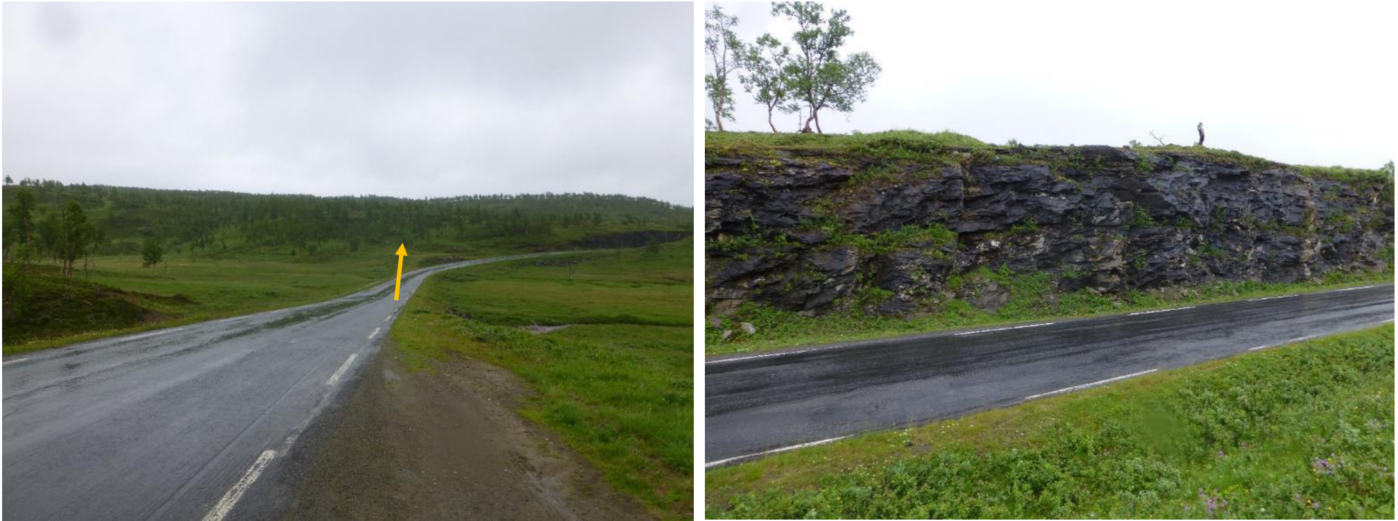
Figur 3: Ljøsenhammer. Bildet til venstre viser oversiktsbilde over området hvor alternativet sitt påhugg er tenkt. Se pil for ca. plassering av påhugget. Bildet til venstre viser bergmassens i bergskjæringen som er synlig til høyre i oversiktsbildet.
