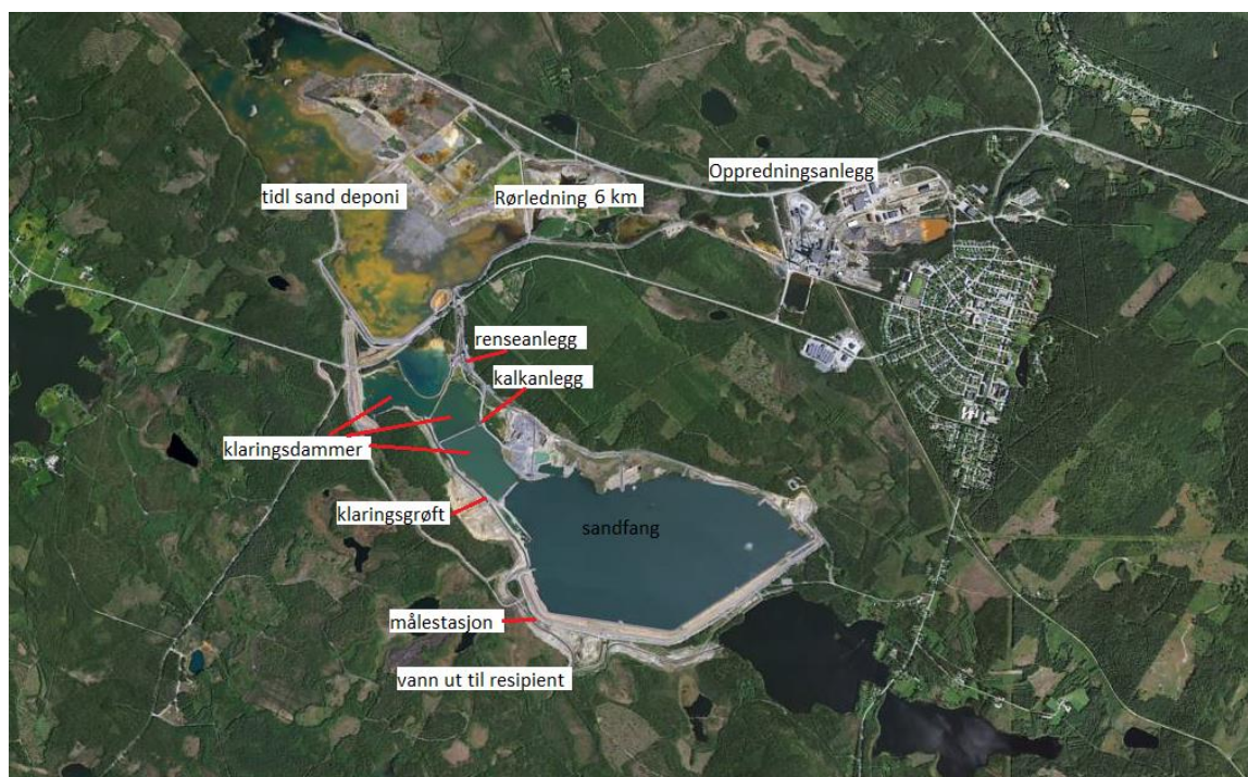
Figur 7. Oversiktsbilde over Boliden Mineral med oppredningsverk og damanlegg. Kilde: Nye Sulitjelma Gruver AS.
