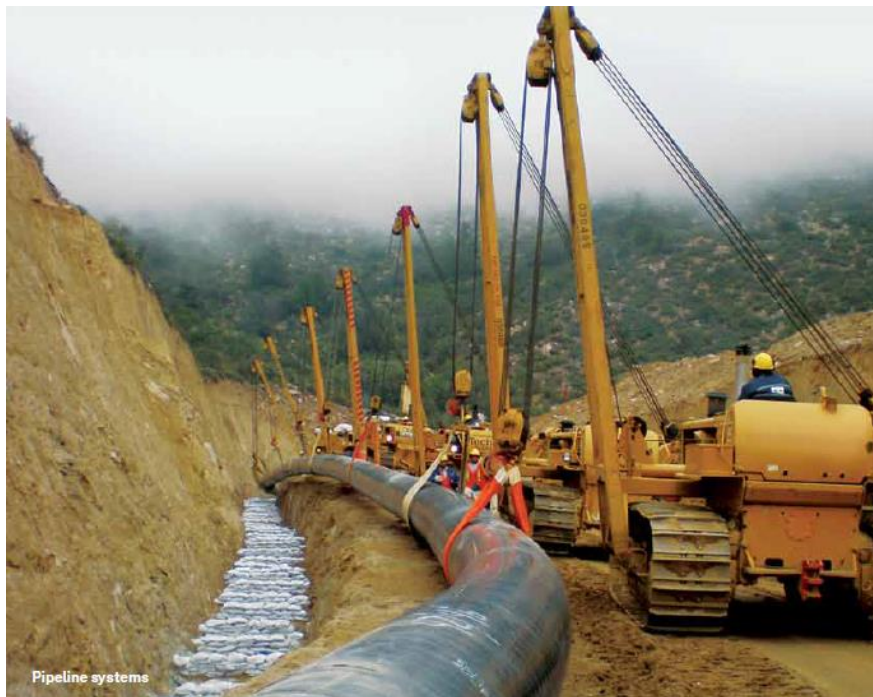
Figur 10. Los Pelambres Maenes / Quillayes Dam, Chile. Legging av rørledning. Kilde: Ausenco.
