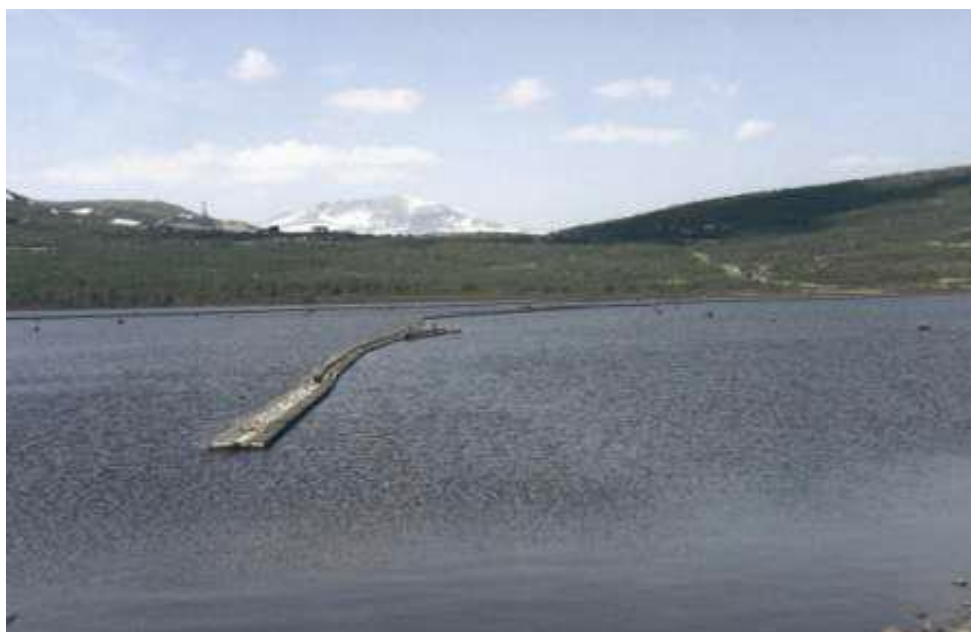
Figur 20. Folldal verk. Hjerkinndammen under drift. Kilde; KLIF 2010.
