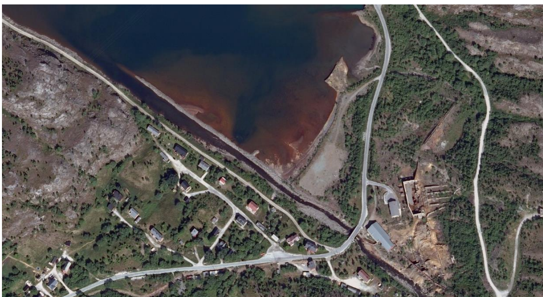
Figur 21 Balmielva har sitt utløp øst i Langvatn ved Fagerli langs området der ruinene fra det gamle smelteverket står i dag. Inngang til Lomi vannkraftverk sees i øst i enden av anleggsveien. I dette området ble sprengstein fra utbyggingen av kraftverket deponert (deponiet på Fagerli).
