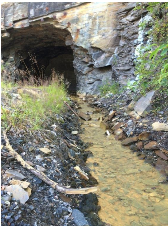
Figur 19 Utslipp av gruvevann fra Bursistoll, som er delvis muret igjen men ikke fylt med vann.
