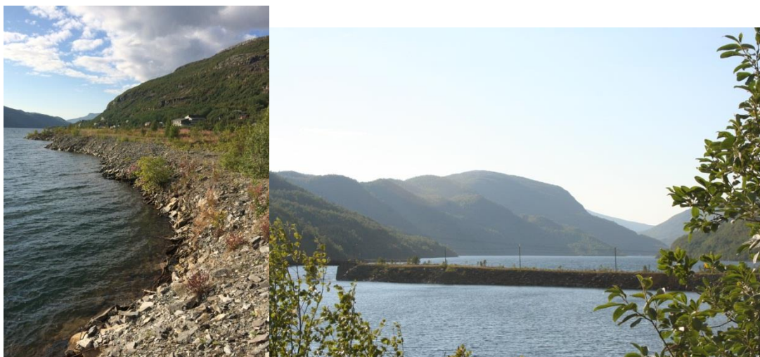
Figur 35 Gråberg er deponert i Langvatnet i hovedsak ved Avilonyfyllingen langs veier og i utfyllingsområder som ved Sandnes og Charlotta.
