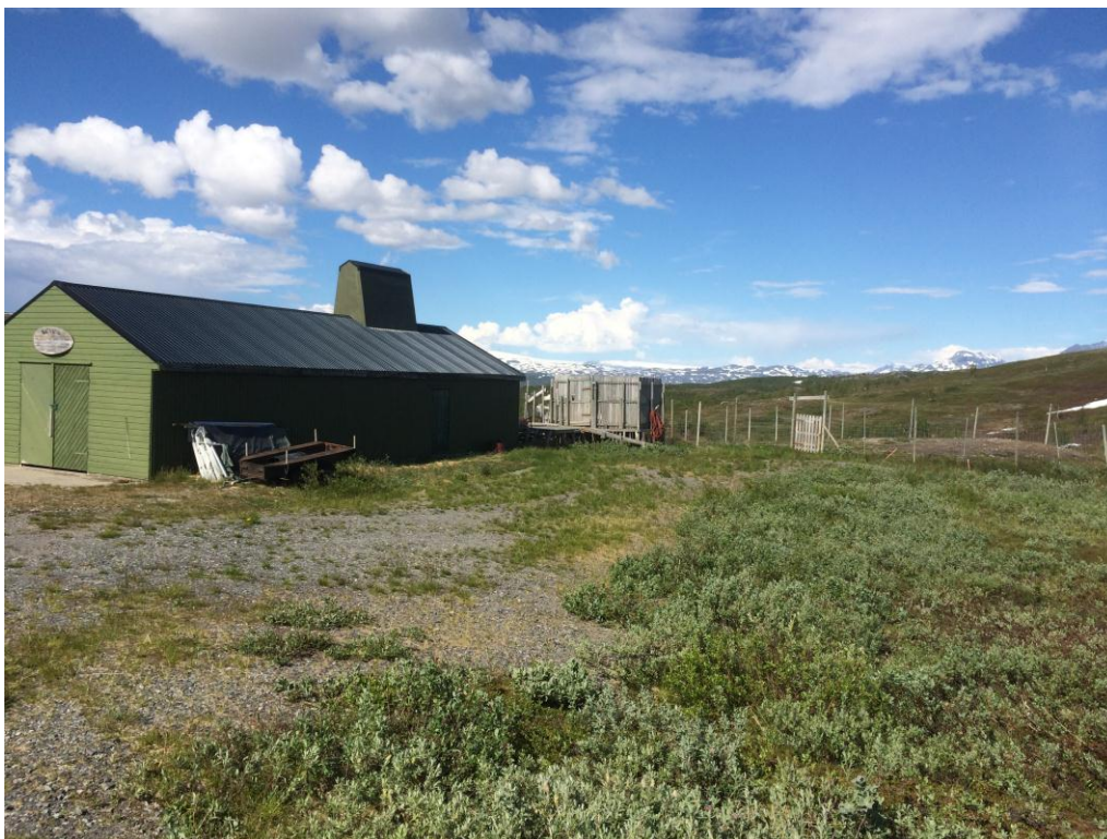
Fig 4.20. Slakteanlegg og gjerde ved Coarvi. Foto 02.07.2014. Norconsult AS. M Selnes.
