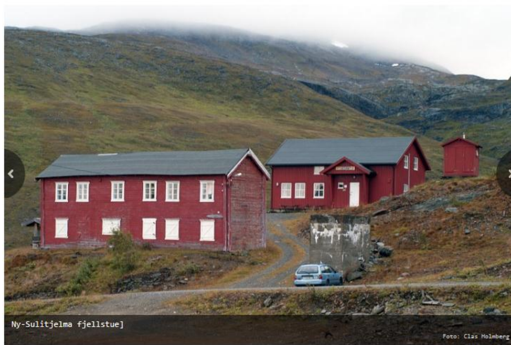
Fig 4.9. Ny Sulitjelma Fjellstue (SOT). Den gamle hytta fra gruveperioden i forgrunnen. Fundament for nedlagt taubane ved bilen. Kilde: Ut.no
