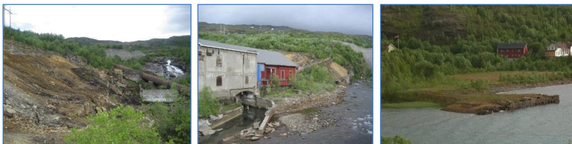
Figur 20. Til venstre industriruin øst for Smeltehytta, i midten kraftverk langs Balmielva. Til høyre malmkaien nedenfor Fagerli.
