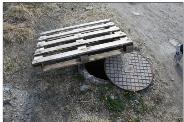
Åpent kumlokk ved enden av parkeringsplassen ved jernbanestasjonen.
