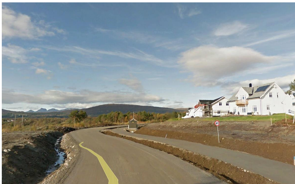
Figur 47. Rognvegen mellom Hauan og Finneid under bygging i 2012. Vegen har nå fast dekke, fartsgrense 50 km/t og belysning. Adskilt gang/sykkelbane. Kilde: Google Earth.
