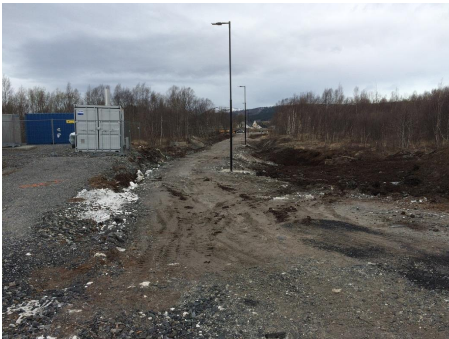
Figur 19: Ny gang/sykkelveg under bygging mellom Eiaveien og Handelsparken. Sett fra Eiaveien mot Handelsparken og Hauan. Foto M Selnes 05.05.2015
