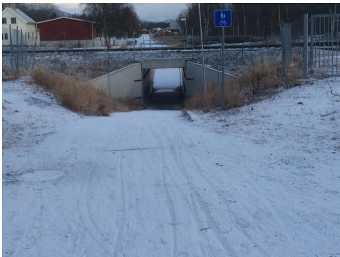
Figur 22. Kulverten mellom Sildreveien og Eiaveien. Foto M Selnes
