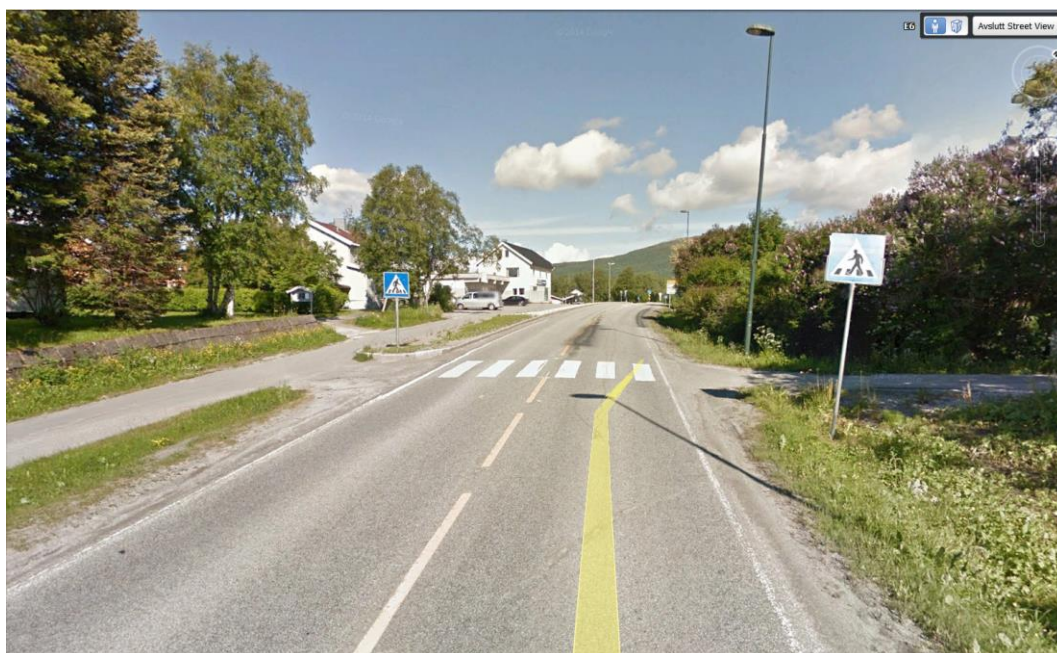
Figur 31. Gangfelt over E6 mellom Balmigata og Triangelveien. Nicokrysset i bakgrunnen. Kilde: Google earth.
