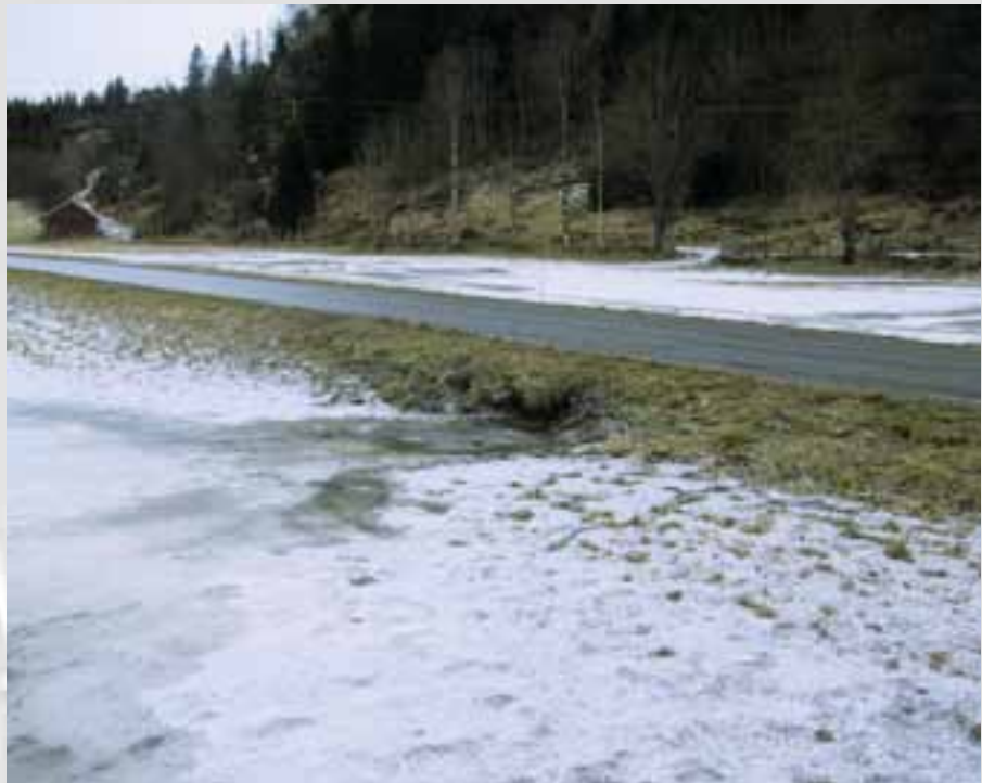
Vatn som kryr opp frå ei stikkrenne under veg og breier seg ut over engareal, danna vinteren 2003 eit samanhengande isdekke og var årsak til vinterutgang. Foto: Arve Arstein
