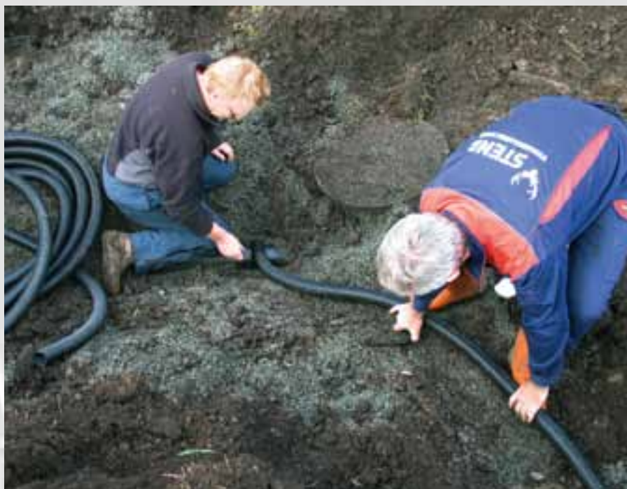
Ennnå uferdig sammenkopling av sugerør og samlerør. Det er praktisk å bruke koblingsdel som er tilpasset, og det må brukes godt med filtermateriale på koblingspunktet. Foto: Bente Opstad.
