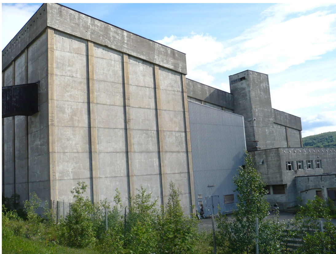
Figur 3.4. Det gamle flotasjonsanlegget på Sandnes
