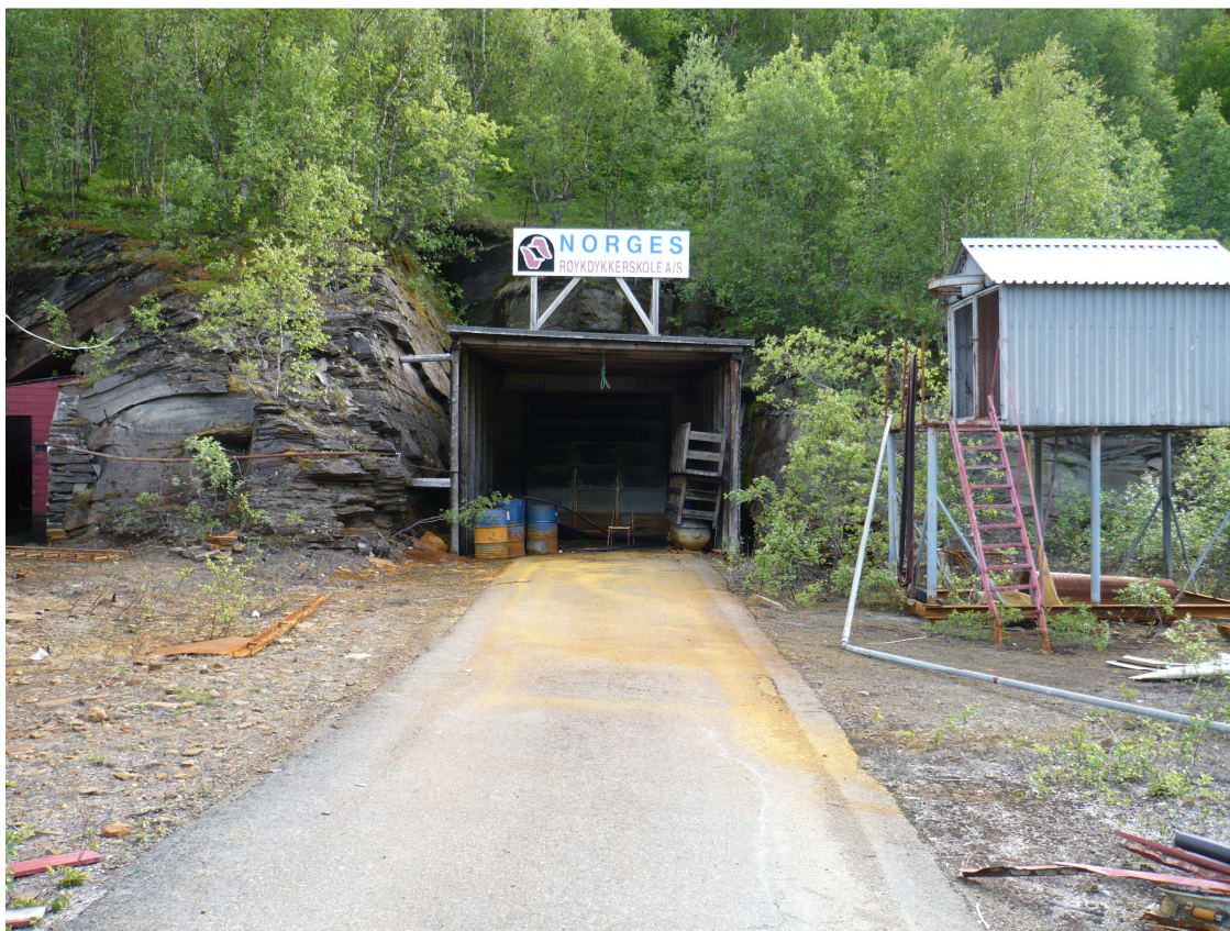
Figur 3.2. Inngangen til Sagmo gruver. Gruvegangen benyttes i dag til trening i røykdykking.
