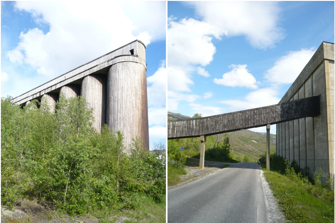
Figur 3.3. Råmalmsiloer (tv. ) og transportbåndet som fører den knuste malmen til møllene for nedmaling (t.h.).
