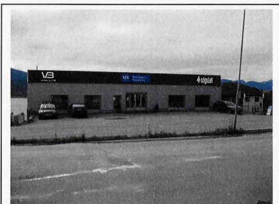
E6, eksist. bygg og parkering sett mot sør/sørvest.
