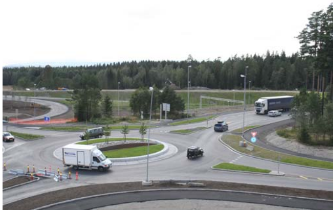
Fra E18 ved Brennemoen
