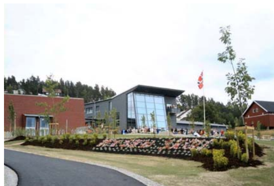
Mysen Skole varmes opp med varmepumpe og jordvarme.
