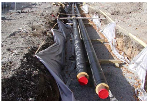
Fjernvarmerør er blitt lagt i Storgaten forbi Kulturtorget
