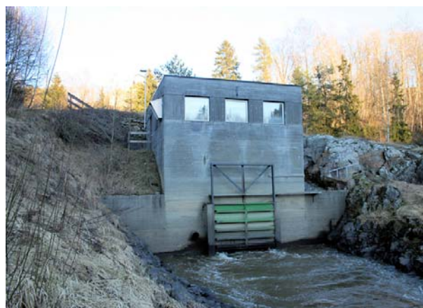
Bilde fra kraftstasjonen i Lekumfossen
